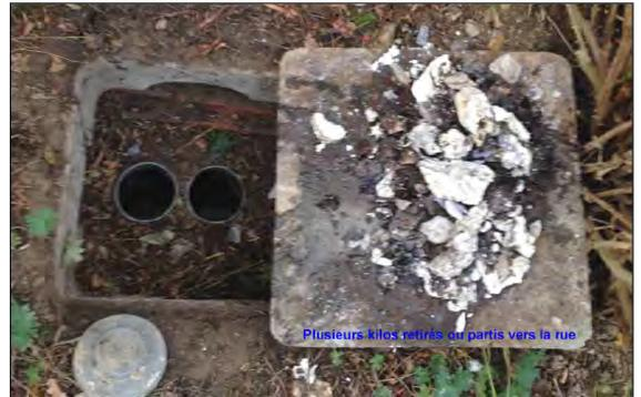
Le tout parfois en mouvement, se déplaçant par plaques et venant progressivement colmater le circuit cuisine et aussi le circuit Toilettes, puisque les deux circuits se rejoignent 5 mètres avant le siphon final extérieur (seul accès possible ici)
